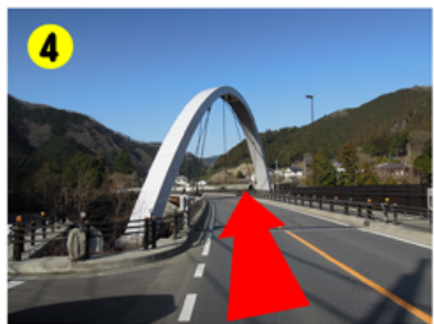
4 アーチ型の道路橋を直進。
