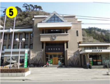
5 右手に村役場。榑原街道(33号)を道なりに進む。
